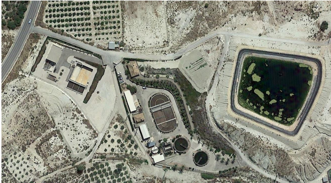
Figura-1: Vista general de la EDAR Abanilla y de la balsa de acumulación de agua tratada para riego (derecha)
